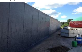
Neue Beschichtung m. Schutzlasur
